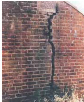
Beispiel 9: Abriss Anbau
